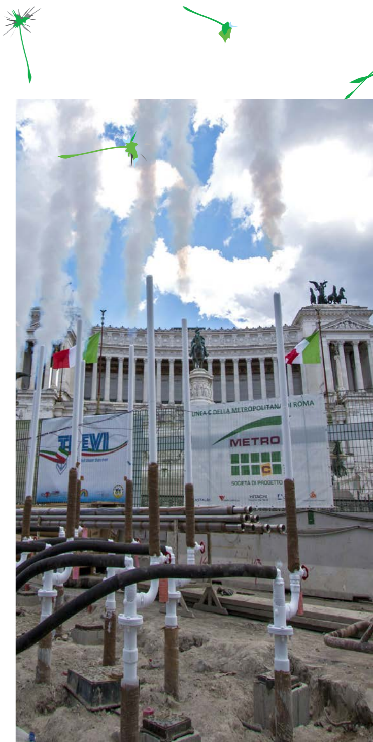
Tecnologia di congelamento per la nuova stazione di Piazza Venezia, Metro Roma, Linea C _ Italia
