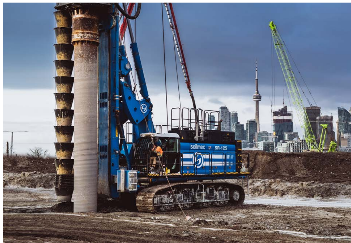
Soilmec SR-125 HIT (in configurazione CSP_ Nord America)
